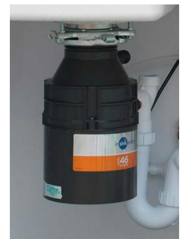
Afb. 45 Shredders voor het vermalen van voedsel- en tuinafval waarna het via de riolering getransporteerd kan worden.
